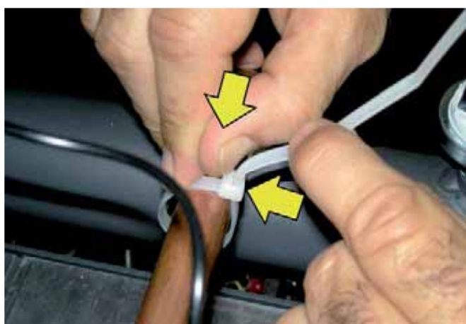
- Uvolněte upevňovací pásky kabeláže v horní části kotle (NEUŘEZÁVAT).
