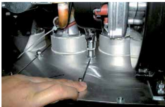
- Odstraňte šrouby "A" každého prvku (trubkovým klíčem 13 mm).
