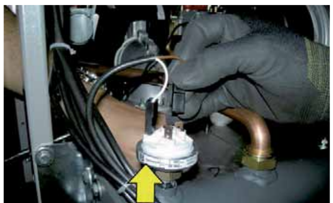
- Odstraňte připojení k plynovému presostatu.
