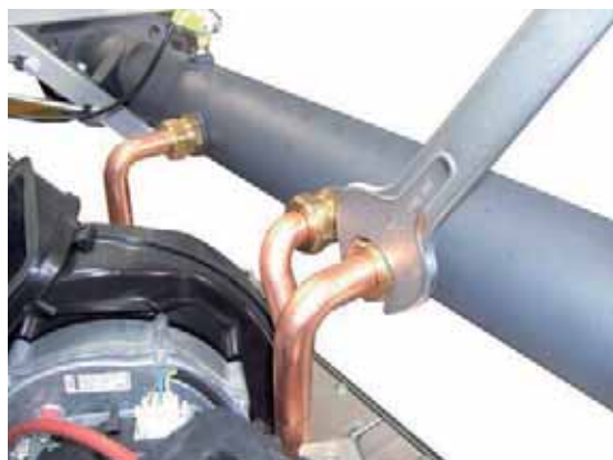
- Odstraňte plynové přípojky z plynového kolektoru pomocí plochého klíče 36 mm.
