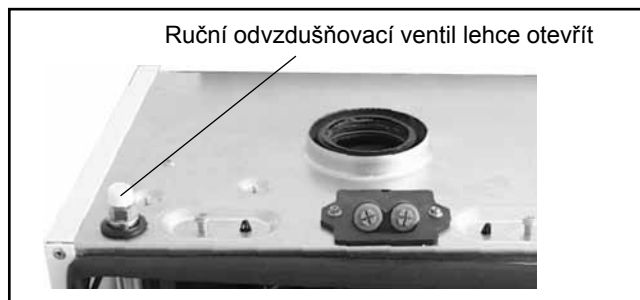
Obr. Ruční odvzdušňovací ventil
