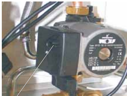
Přepínač stupně čerpadla
