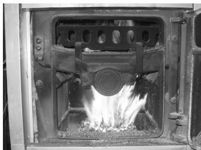
Obr. č. 36 Optimální tvar plamene
