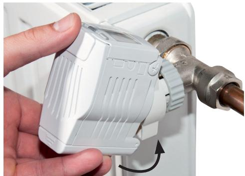
4.5 Pomocí vhodného šroubováku otočte páčku HD13-L směrem k ventilu, pro dokončení montáže.
