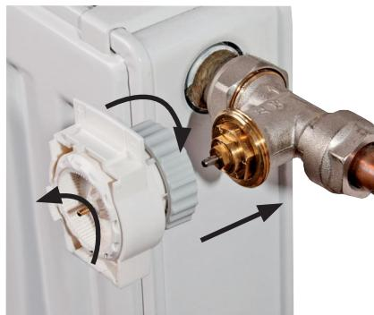
4.2 Pomocí vhodného šroubováku otočte páčku HD13-L směrem nahoru a vysuňte převodovou část z těla hlavice.
