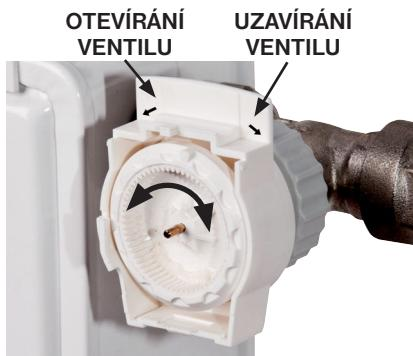
Sejměte těleso z převodové části, ventil nastavte manuálně otáčením ozubeného kolečka dle obrázku.
