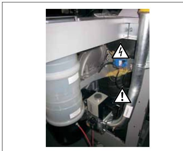
zapalovací transformátor, vysokonapěťová zapalovací elektroda, kombinovaný plynový ventil, hlídač tlaku plynu, ventilátor, spalovací komora
