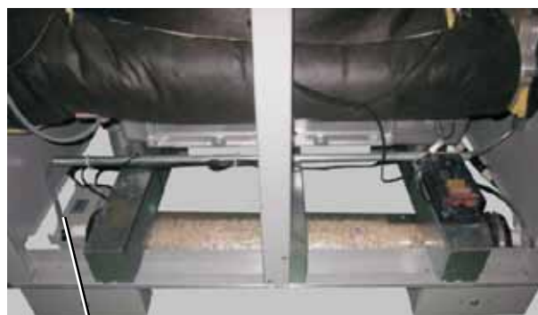
čerpadlo kondenzátu
