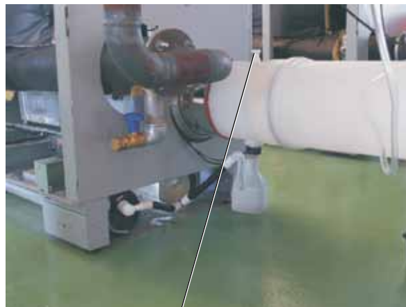
měřící hrdlo na lapači kondenzátu
