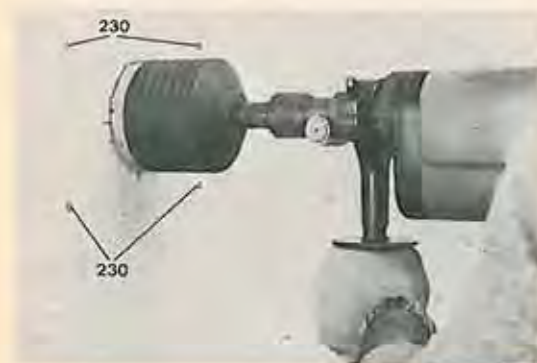
obr. 10 Vrtání průrazu zdi (průměr vrtaného otvoru je 100 mm).
